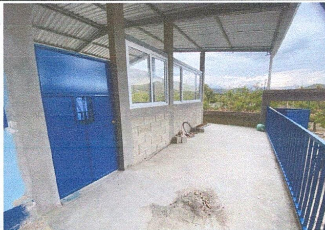
Foto 2: Estructura de techo
